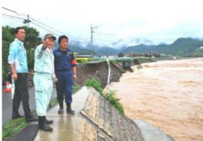
▲花月川の護岸崩落現場を調査する仁比参議院議員(右端)ら=6日、大分県日田市
